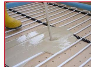
Dieses System ist nicht in der DIN 18560 erfasst und stellt somit eine Sonderkonstruktion dar! Nicht für RTL-Ventile etc. geeignet.
